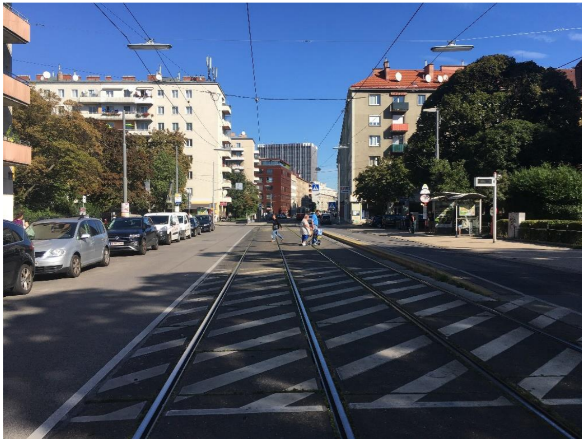
Abbildung 56: Jägerstraße – mangelhafte Querungsmöglichkeit für FußgängerInnen
